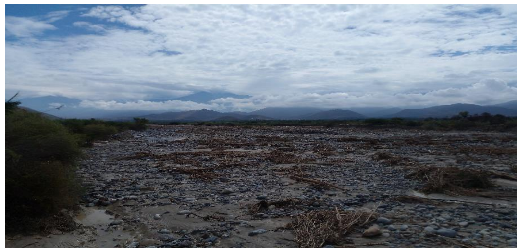
FIGURA N°02: Tramo crítico en el RÍO JIMBE (RÍO NEPEÑA); en el Sector Macracancha, Distrito de Caceres del Peru, Provincia del Santa - Ancash. Vista desde del tramo crítico, se aprecia el cauce del río Nepeña colmatadao a la altura de los predios.
