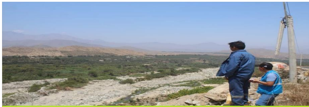
FIGURA N°01: Tramo crítico en el RÍO JIMBE (RÍO NEPEÑA); en el Sector macracancha, Distrito de Caceres del Peru, Provincia del Santa - Ancash. La meta física consta de la limpieza y descolmatación en el Tramo en mencion, conformación de dique con material propio en ambas márgenes y enrocado en la margen derecha..
